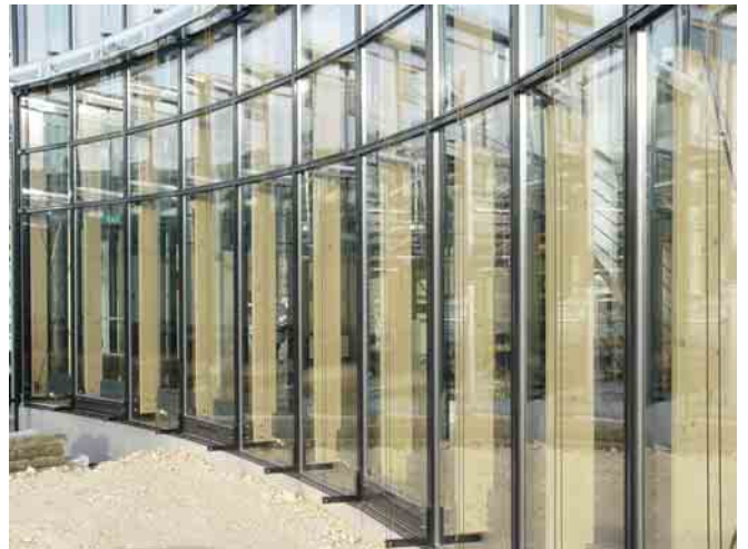
Holz- Stahl- Glasfassade
