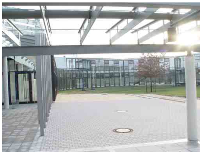
Das Innere der Gebäuderinge
