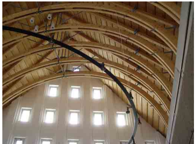
Dachkonstruktion der Klosterkirche
